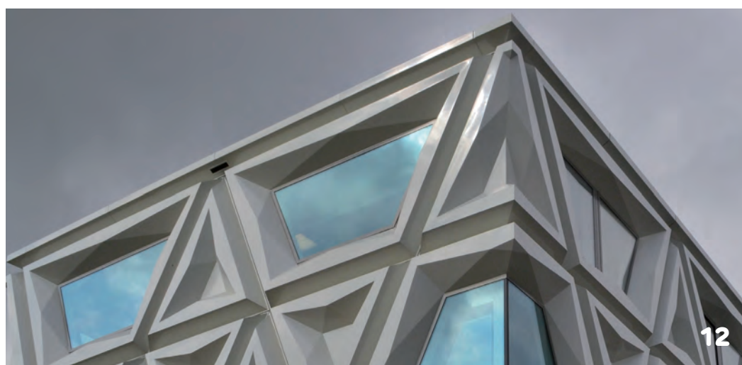
7. Stads Kantoor Utrecht. Oplevering: 2014, architect: Kraaijvanger. Pal op het station komt de nieuwe huisvesting van de gemeente Utrecht. Met meer dan 800 constructieve gevelelementen van composiet. De gevel heeft een isolatiewaarde van RC \approx 11,5 • Foto SkyscraperCity.nl. 8 en 9. Gebouw X van Hogeschool Windesheim in Zwolle (Broekbakema en Holland Composites) werd door de BNA uitverkoren als Gebouw van het Jaar in 2011. Kort daarna ontstonden er scheurtjes in het witte composiet raster • Foto's Henk Wind. 10. Kantoor voor Dienst Sociale Zaken en Werk gemeente Groningen. Opgeleverd 2013, MVSA Architects. De composiet elementengevel is geleverd door Rollocate • Foto Gerard van Beek.
